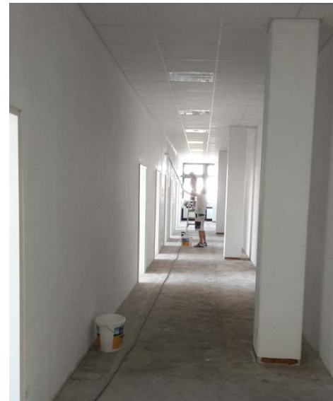
Bild 5 – Beginn der Malerarbeiten
