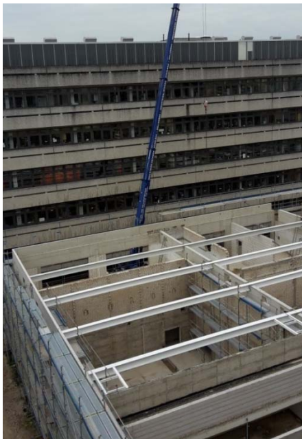
Bild 1 – Verlegung der Stahlträger
