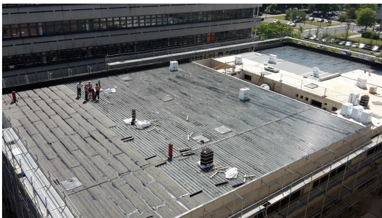
Bild 3 – Beginn der Dachdeckerarbeiten
