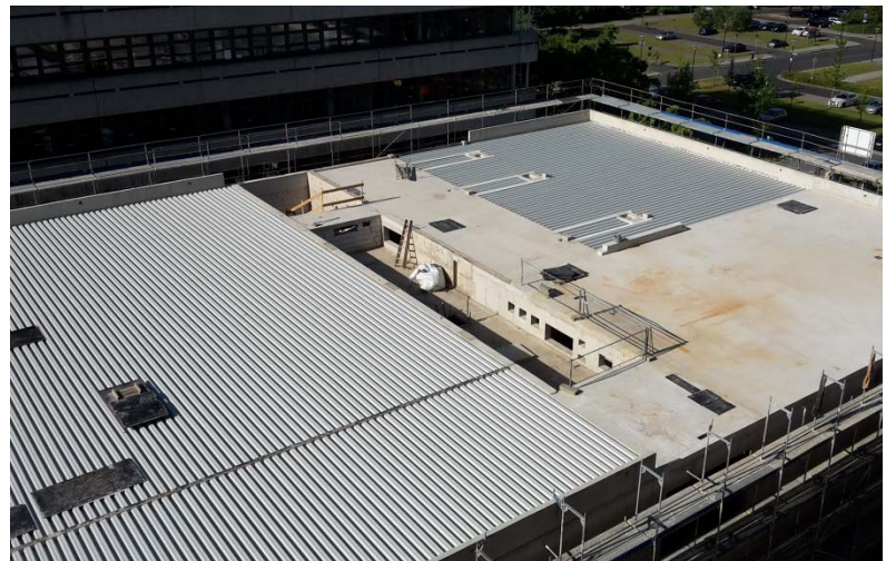
Bild 2 – Verlegung des Trapezbleches
